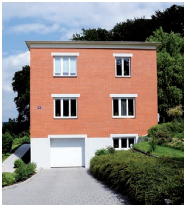
Příklady citlivě řešeného druhotného obvodového pláště baťovských domků.
