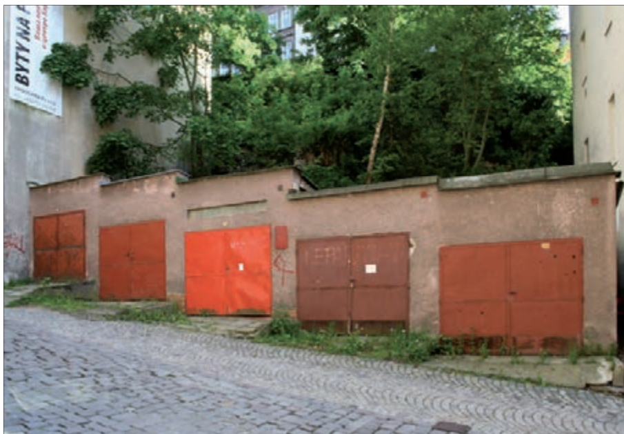
Garáže postavené v proluce mezi činžovními domy jsou jednoznačně hmotově závažné (kategorie D) a lze je chápat pouze jako dočasné využití plochy, jež musí být v budoucnu zastavěna hmotově adekvátní stavbou.
