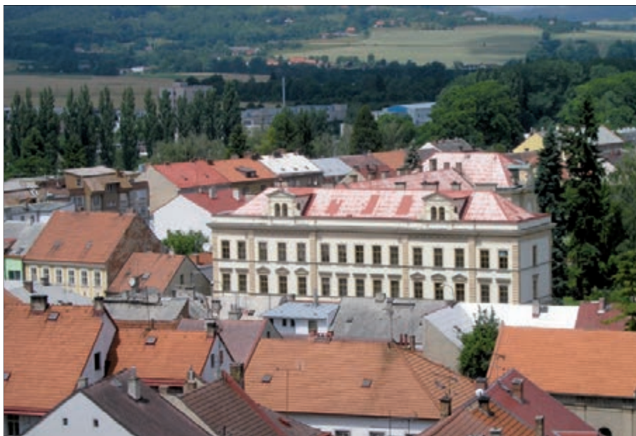
Školní budova se vyčleňuje z okolní zástavby jak půdorysnými rozměry, tak výškou.
