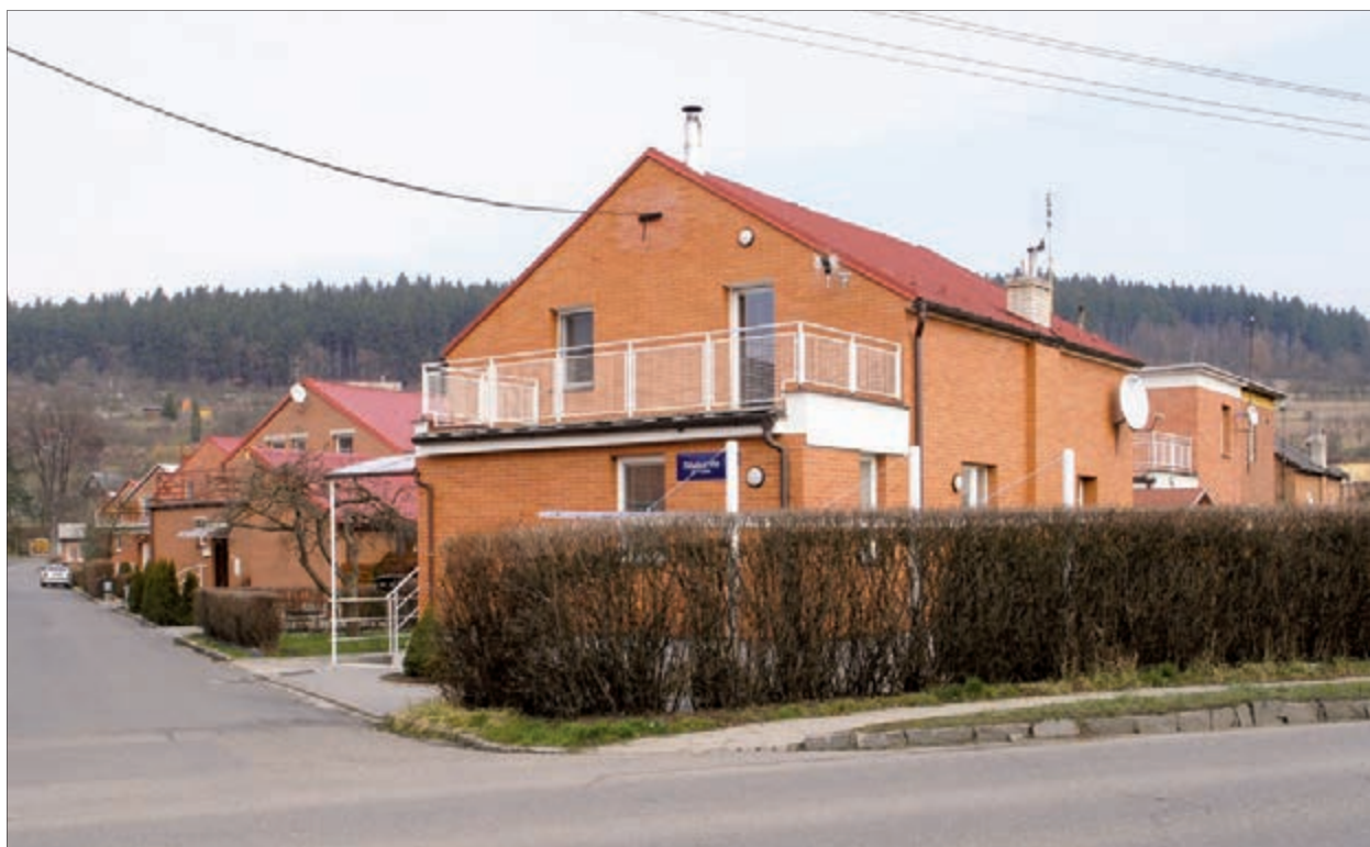
Nové obklady se zcela potlačeným spárováním.
