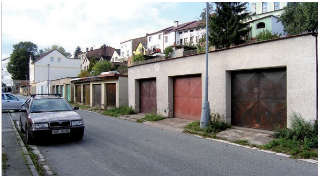
Souviselé fronty garáží v okrajových částech měst lze akceptovat jako kategorii C, i když by místo nich byla vhodnější například řadová obytná zástavba.
