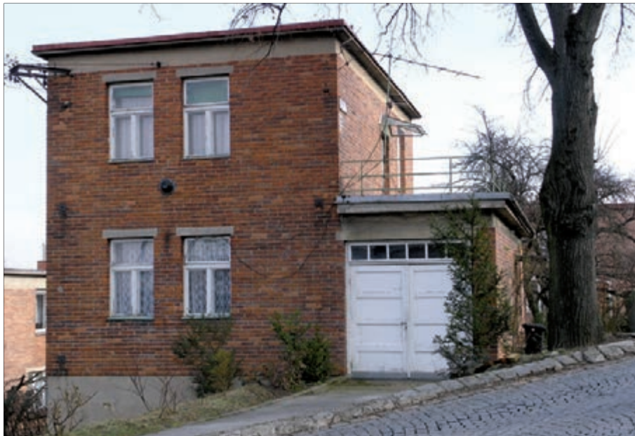
Originální podoba batovského domku s režnou cihlovou fasádou.
